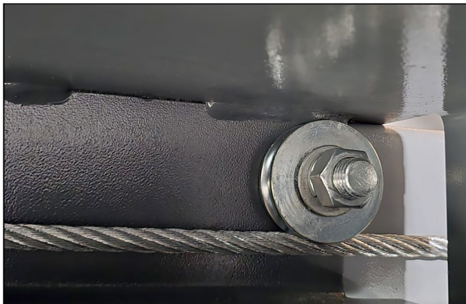
Abbildung: Umlenkrolle unter mittlerer Fahrbahn
