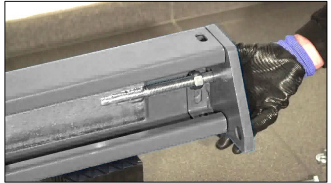
Abbildung: Säulendeckelmontage
