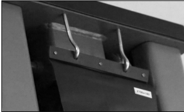
Abbildung: Montage der Säulenschutzabdeckung
