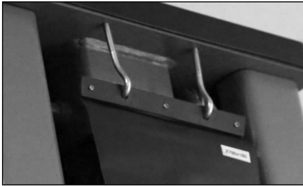
Abbildung: Montage der Säulenschutzabdeckung
