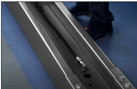
Abbildung: Leitungsschacht Hauptsäule
