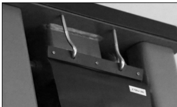
Abbildung: Montage der Säulenschutzabdeckung
