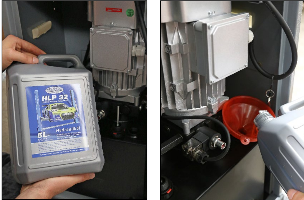
Abbildung: HLP 32 einfüllen
