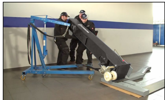
Abbildung: Säule aufrichten
