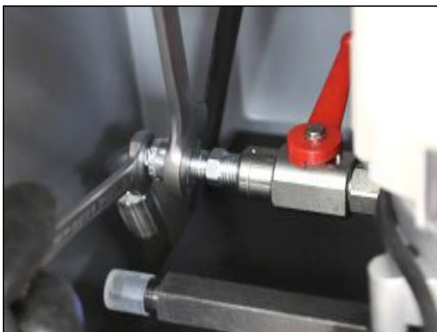
Abbildung: Festziehen der Leitungen
