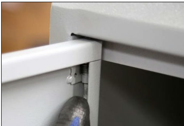
Abbildung: Aushängen der Schaltkastentür
