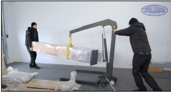
Abbildung: Anheben der Säule
