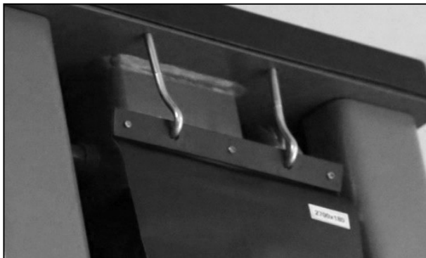
Abbildung: Montage der Säulenschutzabdeckung
